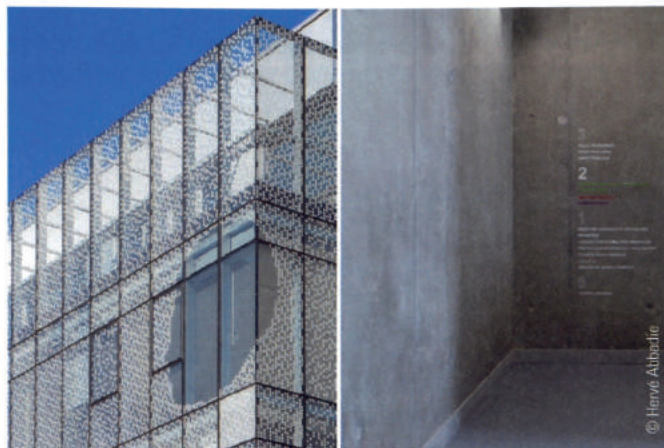
Centre Municipal de Santé - 2017 / La Courneuve (93) - Construction d'un centre municipal de santé, d'un restaurant municipal et d'un parking - Surface: 3 400 m 2 SDP / Montant: 9 500 000 € HT
