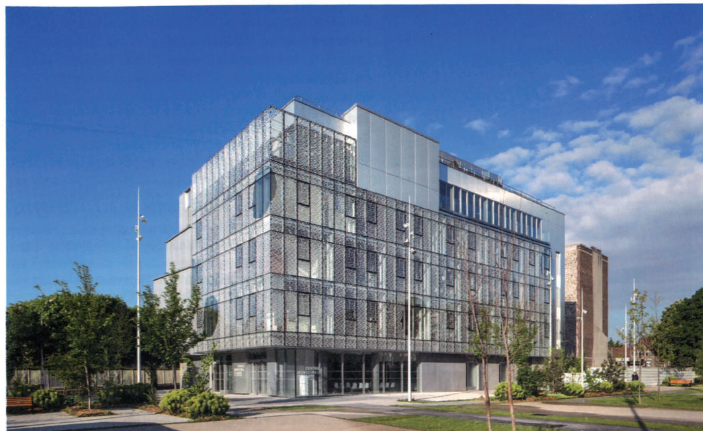
Centre Municipal de Santé - La Courneuve
