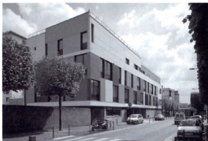
Centre Municipal de Santé - 2007 / Vitry-sur-Seine (94) - Construction d'un centre municipal de santé - Surface: 2 500 m 2 SHON / Montant: 5 000 000 € HT
