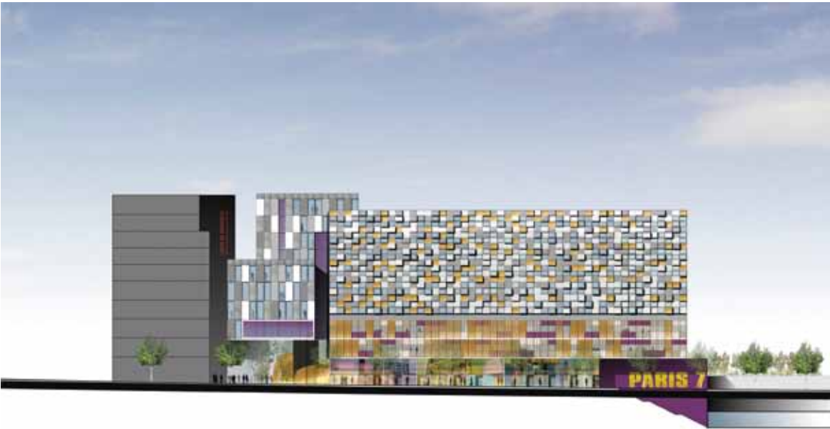
Façade boulevard Jean Simon / Boulevard Jean Simon façade
